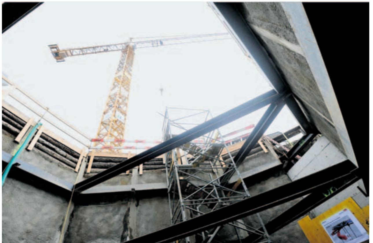
Mit Stahlträgern, Baumstämmen und Beton ist die sieben Meter tiefe Baugrube gesichert. Bei Regen füllt sie sich mit Abwasser. Bild: Donato Caspari
